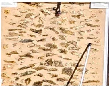
Des pierres non taillées, de formes et de dimensions différentes, sont construites en opus incertum ou « appareil irrégulier » empilées sur une bonne dose de mortier. Un joint beurré en mortier de chaux coloré d'un ton brique assure la consolidation du parement.
