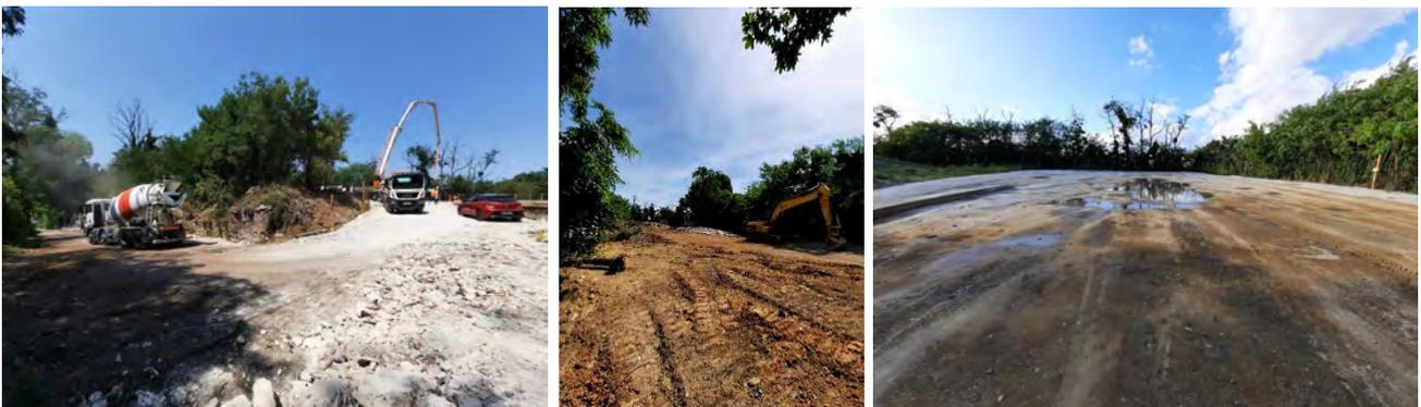
Il s'est ensuivi environ 10 mois de travaux de comblement, consistant à acheminer les déblais déposés en zone de stockage jusqu'au tréfonds de la carrière.
