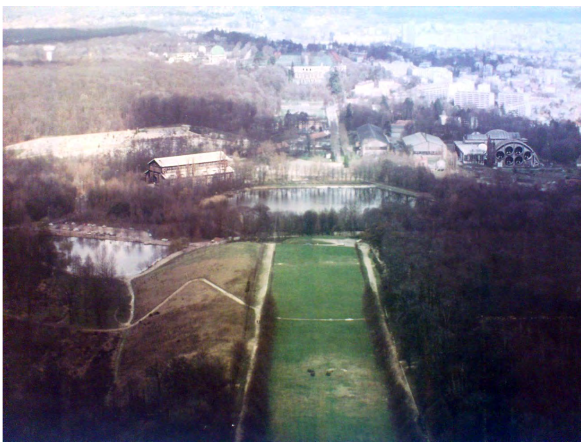
Vue aérienne du site de Chalais-Meudon depuis le sud - 1978 - cliché Gendarmerie Nationale
