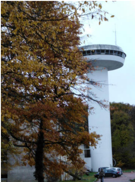
Figure 1. Majestueusement dressée à l'orée du bois, la tour solaire est un bâtiment énigmatique pour la plupart des habitués du site. Rares sont les privilégiés qui ont eu la chance d'y observer le Soleil ou même d'admirer la capitale du haut de ses 35 mètres. La tour est pourtant l'un des instruments solaires les plus performants au monde avec son spectrographe de 14 mètres et le miroir de son télescope de 60 centimètres de diamètre. Elle est encore un outil de recherche et d'enseignement pour la communauté solaire française. (Photo B. Schmieder, crédit R. Lecocguen)
