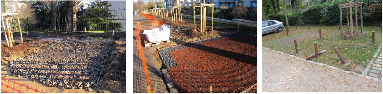
*Aménagement d'une aire de stationnement : « evergreen » superposé à un sous-bassement en pierres ; un petit plot d'angle déchaussé.*
