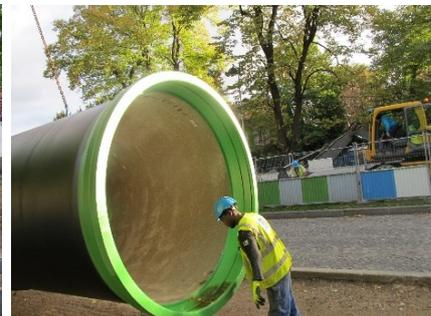
*Installation d'un réseau souterrain de captage des eaux de pluie d'orage depuis la rue de l'abbaye ; vérification du joint en plastique jaune qui assure le raccord entre deux tubes.*
