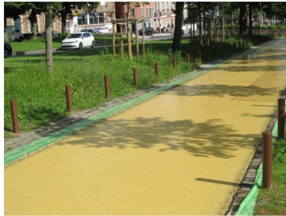
*Colmatage des « nids de poule » par une couche de bitume recouverte ensuite par un agglomérat stabilisé.*
