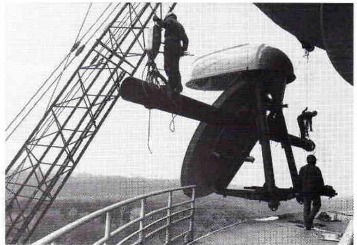
Installation d'une antenne "large-bande" sur une plate-forme de la tour de Meudon à la hauteur de 60 mètres, à l'aide d'une grue.
