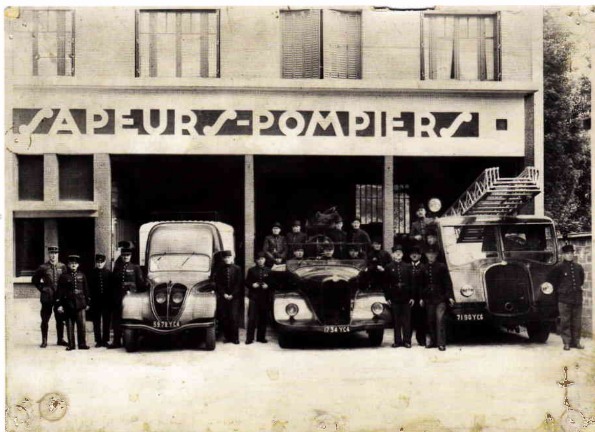
Les sapeurs-pompiers de Meudon devant leur nouveau bâtiment dont la construction fut décidée lors de la réunion du Conseil Municipal le 14/2/1930 (photo ; AMM , cote 4Fi2948).
