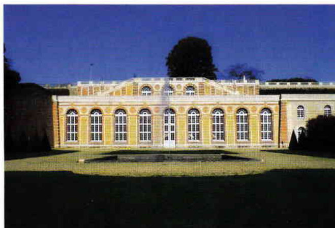
La façade de l'Orangerie, récemment restaurée
