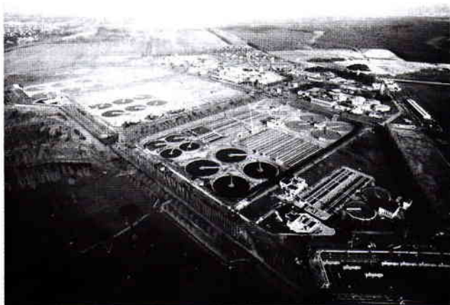
La station d'épuration d'Achères, point de convergence des eaux usées du Val-de-Saine (cliché : S.I.A.P.)
