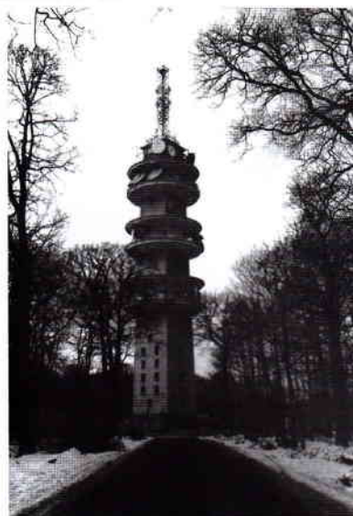
La tour hertzienne de Meudon en janvier 1987 (Cliché : Régis Delbecq)
