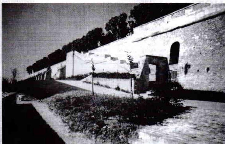
Domaine National de Meudon : Au pied de la Grande Terrasse, la promenade à l'est vue du nord vers le sud avec l'escalier d'Aristote qui relie l'une à l'autre par sa voûte nord restaurée (Cliché : Philippe Canac).
