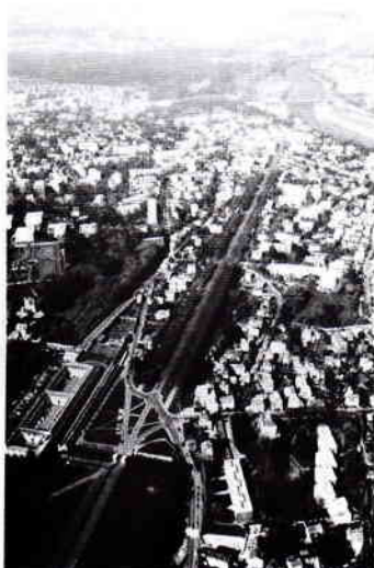
Vue aérienne de la Grande Perspective (à partir de la terrasse) et des coteaux de Bellevue, avec, dans le fond, une partie de l'île Séguin et le pont de Scierres (Cliché : MISSION D'ÉTUDE POUR LE SITE DE BILLANCOURT)
