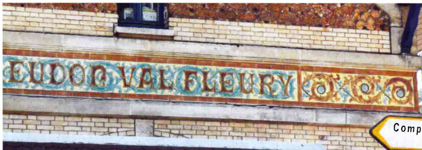
Fig. 3 - Gare de Val-Fleury : bandes horizontales en céramique
