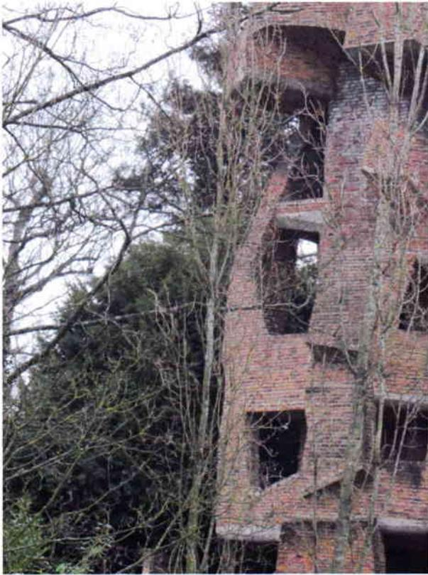
**Fig. 5a - La tour Bloc : assemblage de briques sur une structure en béton.**
