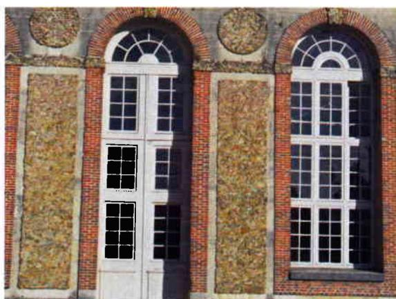
*Fig.24 - La façade de l'Orangerie : entre deux fenêtres, parement en pierres de meulière.*
