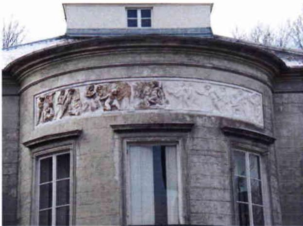
**Fig. 16 - La façade de la maison Huvé au Bas-Meudon : édifice en plâtre et mortier construit à la fin du XVIII<sup>ème</sup> siècle. La fresque, rénovée récemment, est en terre cuite ; elle a été réalisée à la gloire des arts.**
