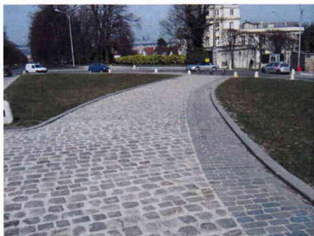
*Fig. 22b - Assemblage des pavés des allées sur la place Janssen : les bordures des trottoirs sont en granite gris-bleu provenant des Côtes d'Armor en Bretagne.*
