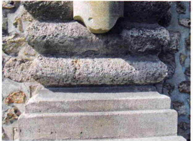
*Fig. 12b - Détail de la base d'une gaine où l'on reconnaît trois faciès différents de calcaire lutétien.*
