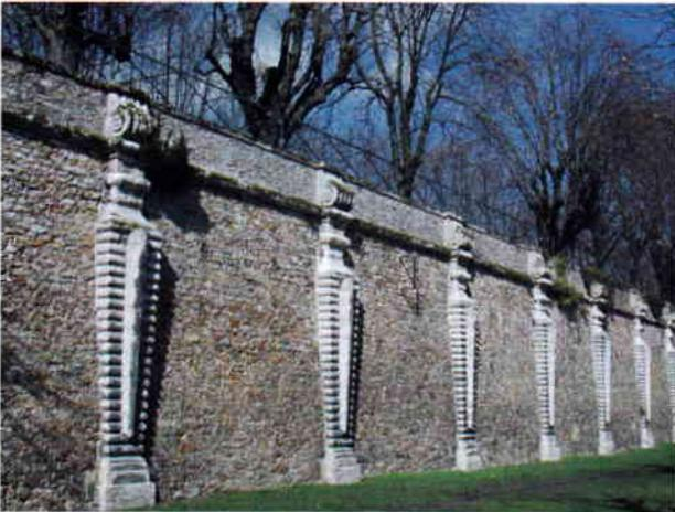
*Fig.11 - Le mur de soutènement de la terrasse de l'observatoire.*
