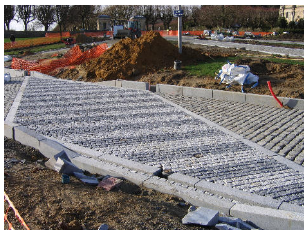
Fig. 9 - Un exemple de passage protégé en cours d'aménagement.
