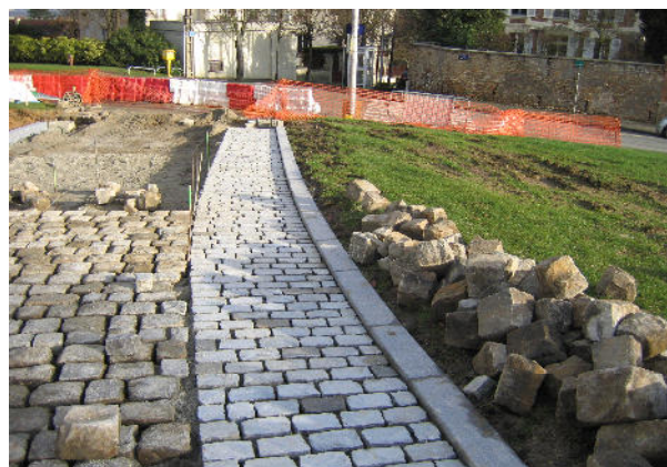
Fig. 4 - Un cheminement piétonnier à revêtement de pavés sciés.
