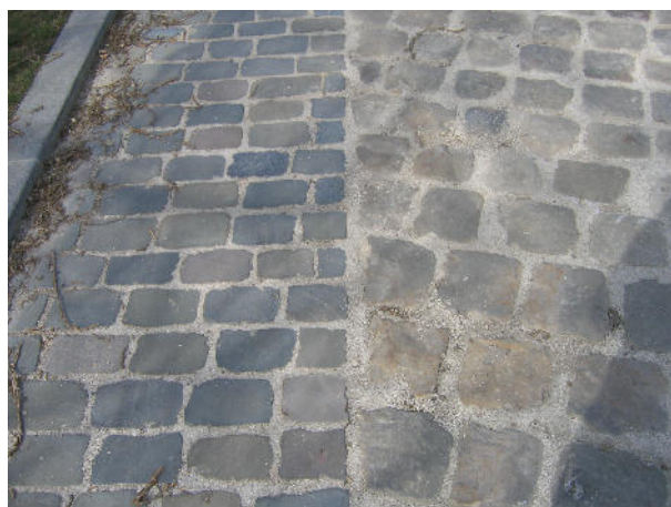
Fig. 3 - Revêtement en pavés de grès sombres dans l'allée centrale.
